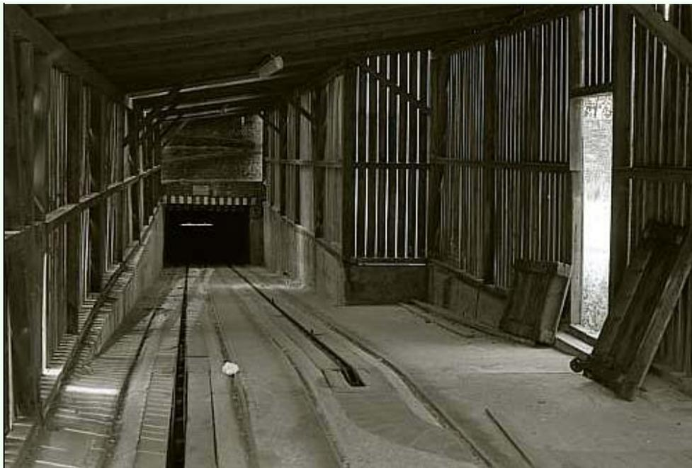
**Abwärts:** Blick zum Tunnel vom Werkgelände aus. Zwischen den Schienen der beiden 750-mm-Gleise ist jeweils die Vorrichtung für die Unterflur-Kettenförderung zu sehen. (28.06.1983)
